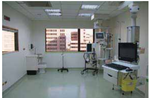
ICU創新設計—吊塔
