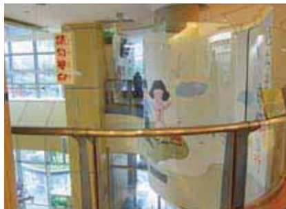
2樓圍欄由120公分改成160公分，預防兒童墜落
