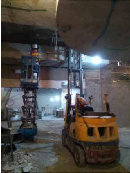
▲ 廚房老舊水泥風管拆除
