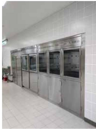
▲ 雙通雙開保溫櫃 / 冰箱隔間採雙通設計以管制物流動線並提升空間使用效率
