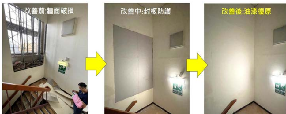
▲ 東址病房樓梯牆面破損改善
