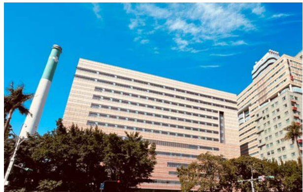
▲ 健康大樓主體結構
