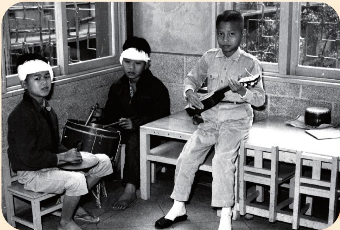
1960年 西址小兒科病房遊戲室
